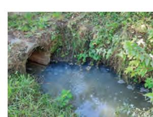
что через железобетонную трубу приблизительного диаметра 300-500 мм осуществляется сброс пенной жидкости мутного цвета с характерным запахом.
